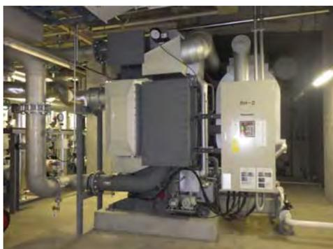
更新した吸収式冷温水発生機
