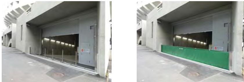
アリーナへの浸水対策として搬入口前に設置した防水設備
