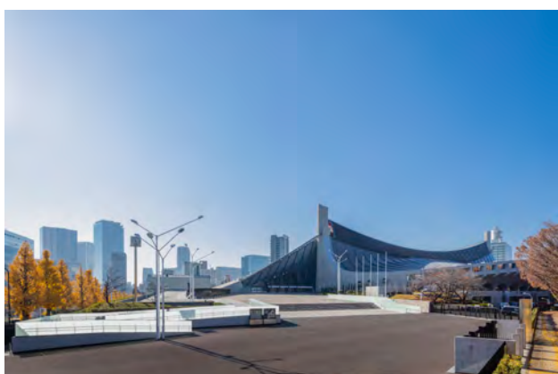
改修後の原宿プラザ
