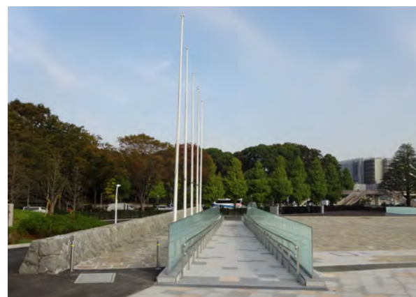
原宿プラザに新設したスロープ
