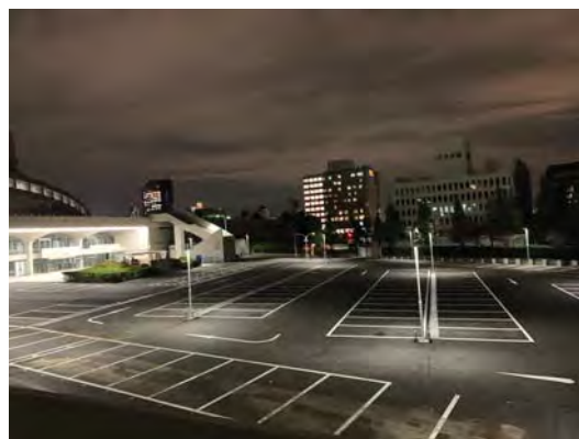
改修後の南駐車場
