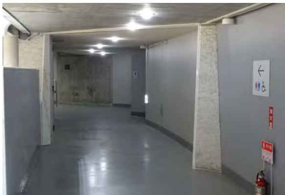
改修後のアリーナ通路
