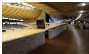
現状のコンコース腰壁
