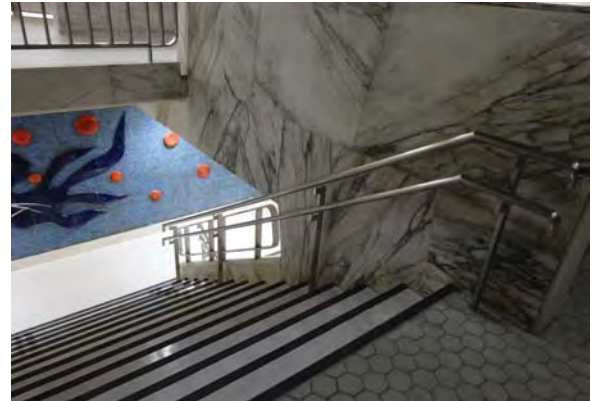
新設の南ロビー階段手すり
