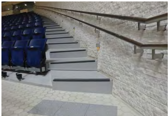
新設の観客席階段手すり
