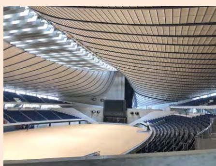
改修後 第一体育館内観
