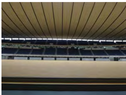
改修後のアリーナ床（南側階段）
