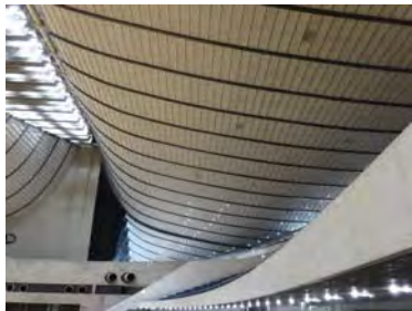
改修後 天井内スピーカーを設置
