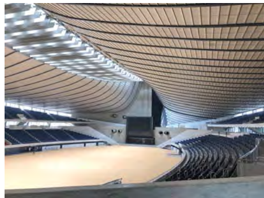
改修後のアリーナ照明
