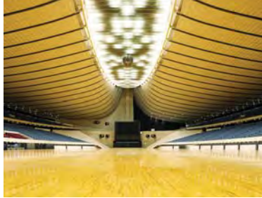
改修前のアリーナ天井
