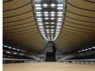
改修後のアリーナ天井
