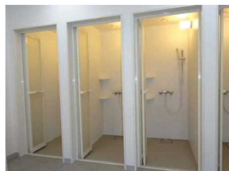
改修後のシャワー室
