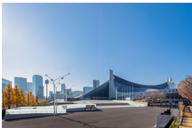
改修後の原宿プラザ
