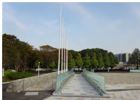
原宿プラザに新設したスロープ
