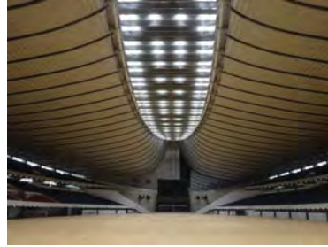
改修後のアリーナ天井
