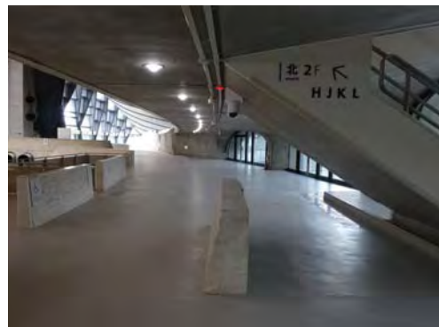
1階コンコースに設置した監視カメラ
