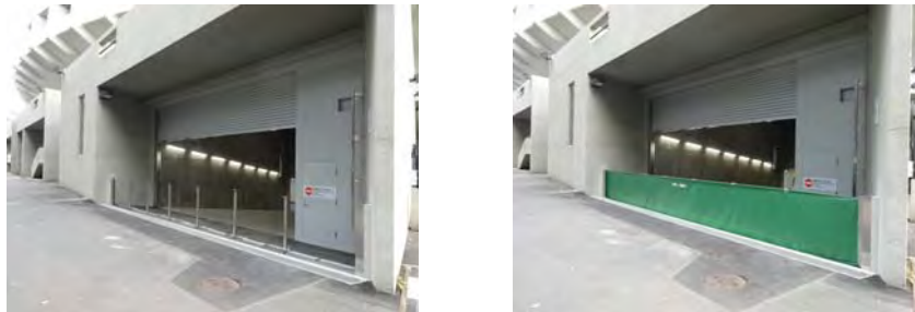
アリーナへの浸水対策として搬入口前に設置した防水設備
