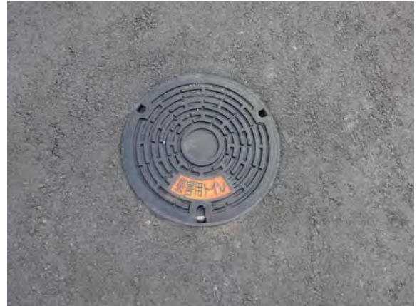
南駐車場に新設した災害トイレ用マンホール
