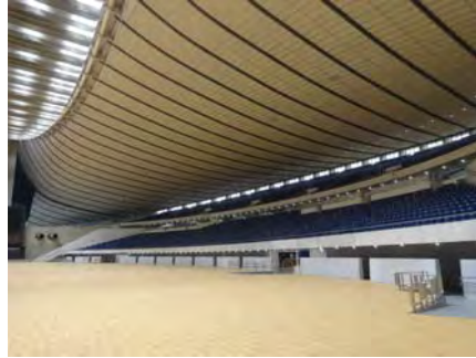
改修後のアリーナ床（北側スロープ）
