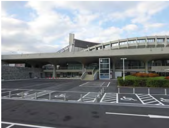
南駐車場に整備した車いす使用者用駐車スペース
