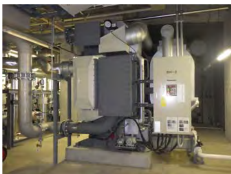
更新した吸収式冷温水発生機
