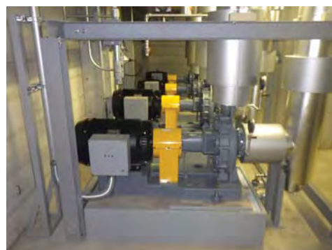
更新した冷温水ポンプ
