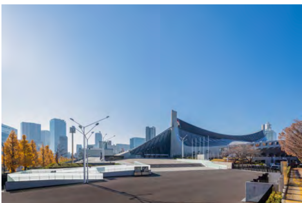
改修後の原宿プラザ
