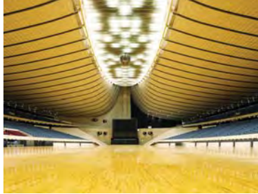
改修前のアリーナ天井
