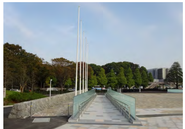
原宿プラザに新設したスロープ
