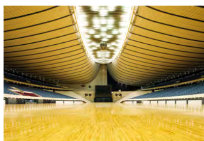
改修前のアリーナ天井
