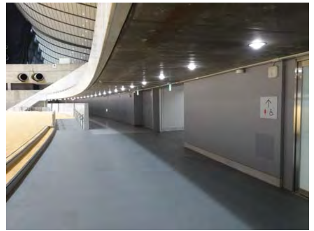
改修後のアリーナ通路壁面（連続繊維補強シート施工面）
