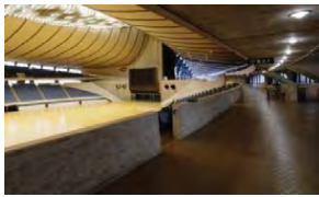
現状のコンコース腰壁
