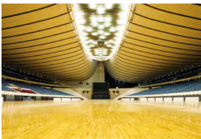
改修前のアリーナ天井
