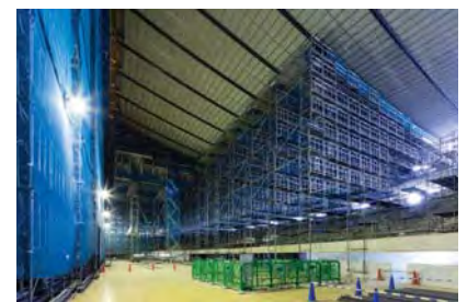
改修のために設けられた足場
