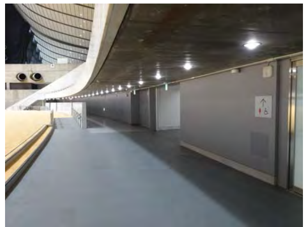
改修後のアリーナ通路壁画（連続繊維補強シート施工面）
