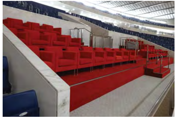
改修後の来賓席（車いす使用者席及び手すりを新設）
