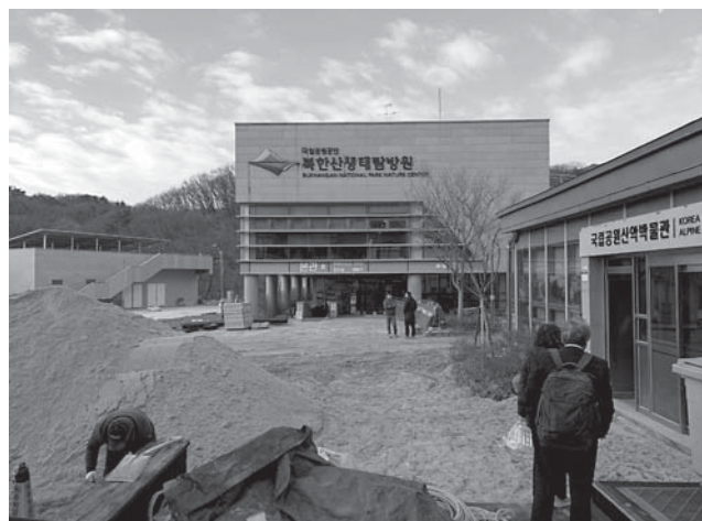
竣工直前の施設
