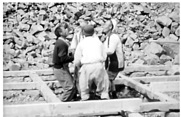
図4 手作業で4人がかりで重しを上下させ、基礎を固める様子
