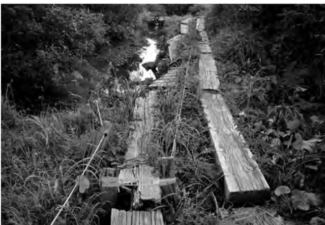
写真9 八幡平、老朽化が進行している湿原保護のために敷設された木道
