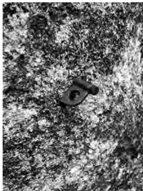
写真5 瑞牆山で見られる老朽化が進む支点
