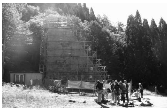
大規模改修中のロッククライミング訓練施設
