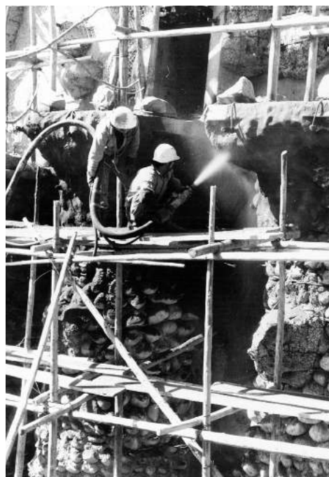
モルタルの吹き付け作業
