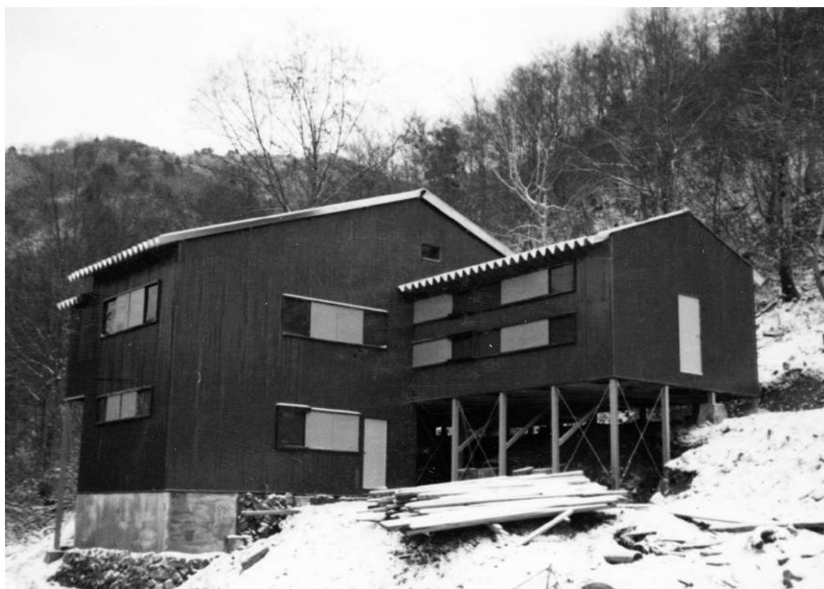
竣工した前進基地
