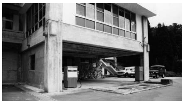
所内に設けられた給油機
