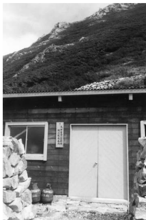
竣工当時の前進基地（正面入口）
