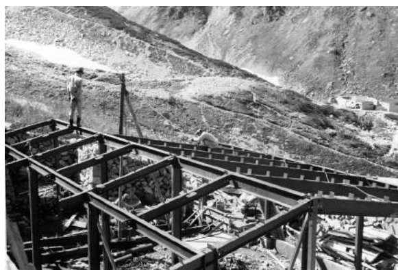
建設中の前進基地
