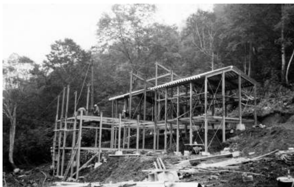
建設中の前進基地
