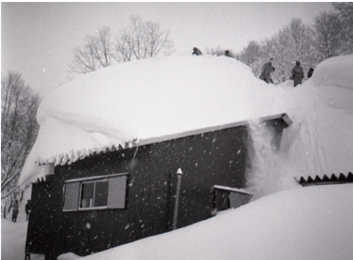
冬山前進基地（昭和 44 年 11 月 29 日竣工）の雪下ろし
