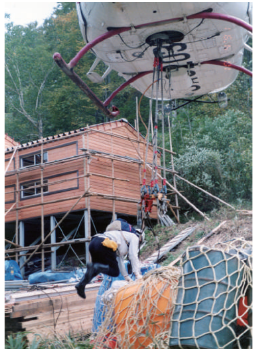
冬山前進基地の改修工事（平成3年度）
