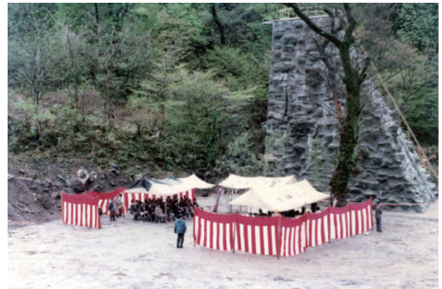
ロッククライミング訓練施設（昭和 46 年 3 月 31 日竣工） の竣工式（同年 5 月 8 日）
