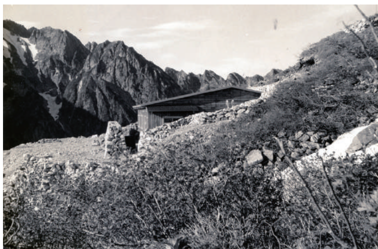
夏山前進基地竣工（昭和 43 年 10 月 23 日）
