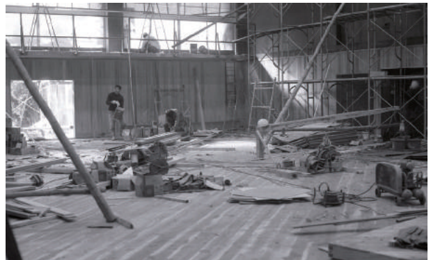
トレーニング室の建設（昭和 49 年）
