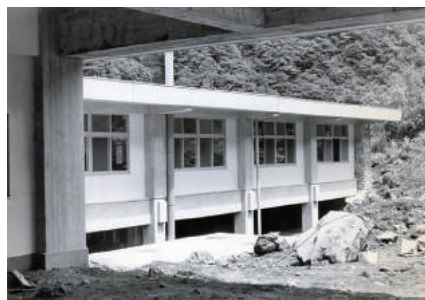
本館資料室方向 開所当初は大浴場などがなかった
