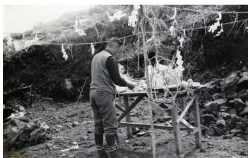
夏山前進基地（剣沢）着工式 （昭和 43 年 8 月 11 日）
