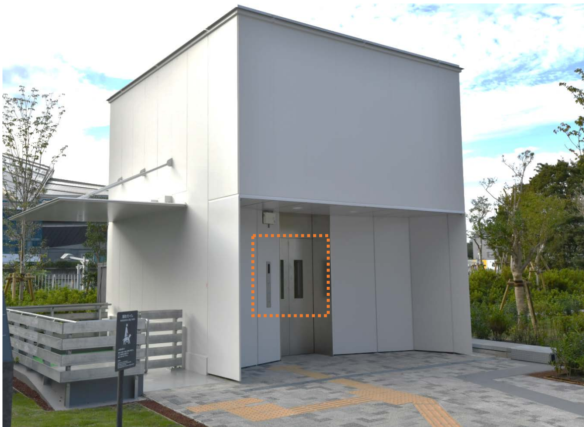
<外部用エレベーター>
