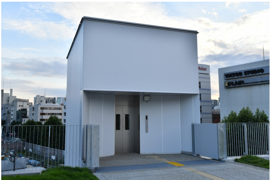
<外観：外部用エレベーター>
