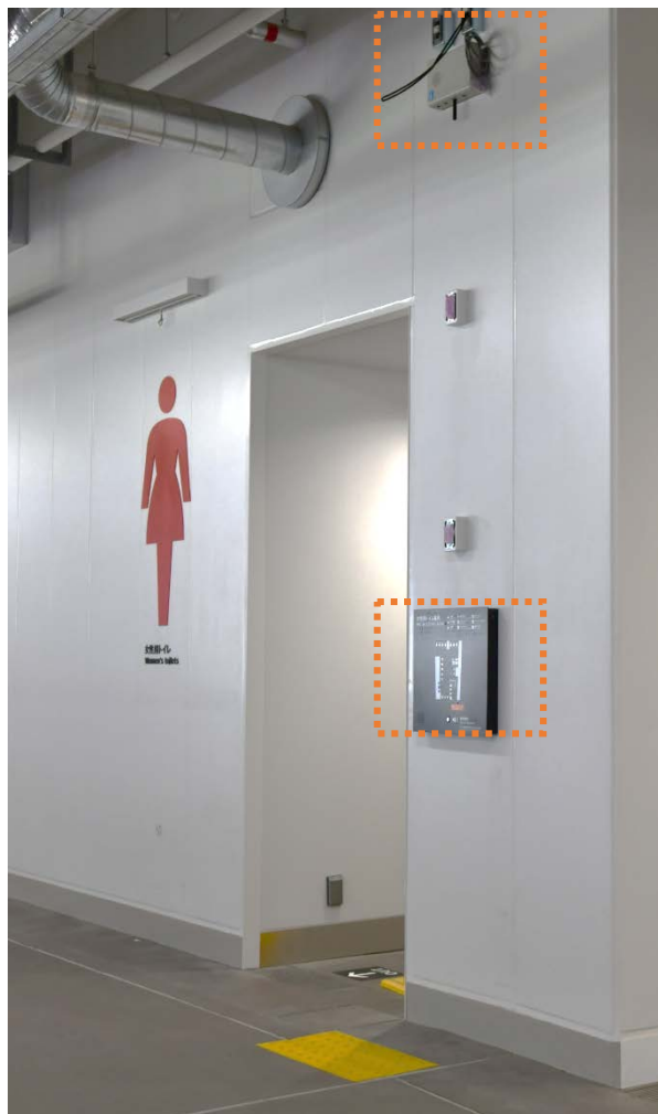
<女性用トイレ入口付近>
