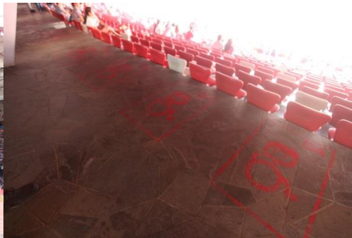
車いすのサインだけ、手すり無し
