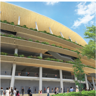
庇と柱の軸組で構成された外観
