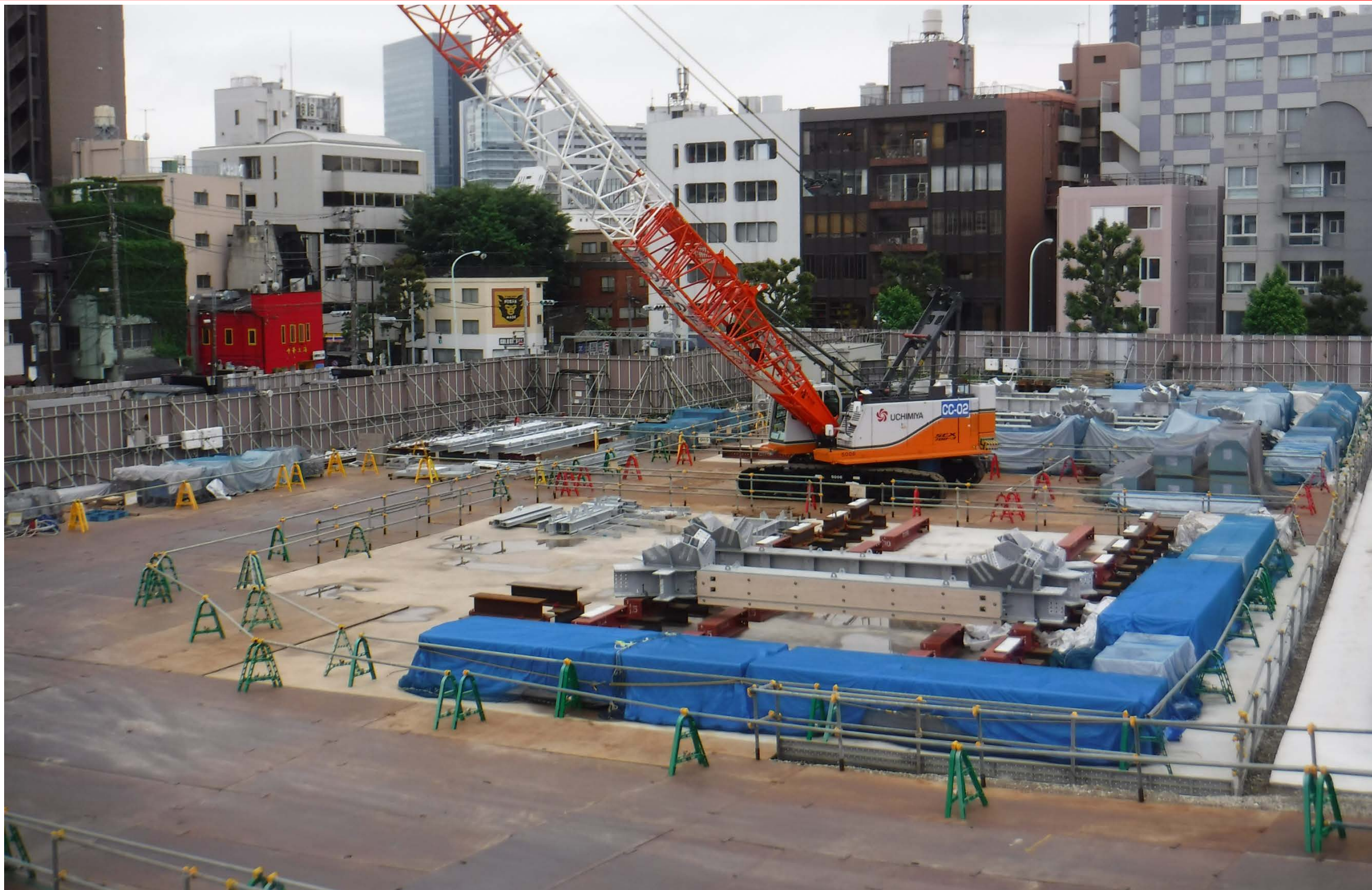
写真③ 木材取付作業場所
