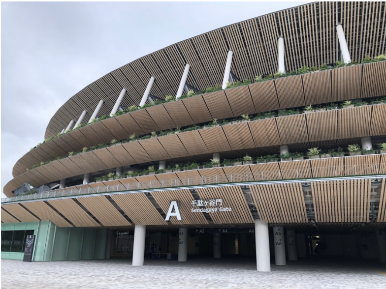
自然の風をスタジアムに取り込む「風の大庇」 (北側エントランスゲート周辺)
