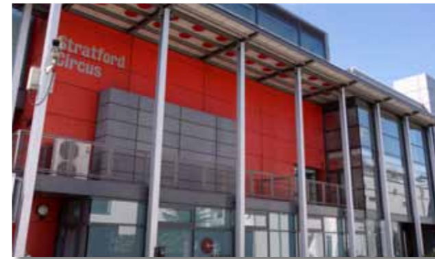
マルチサポート・ハウス(外観)
