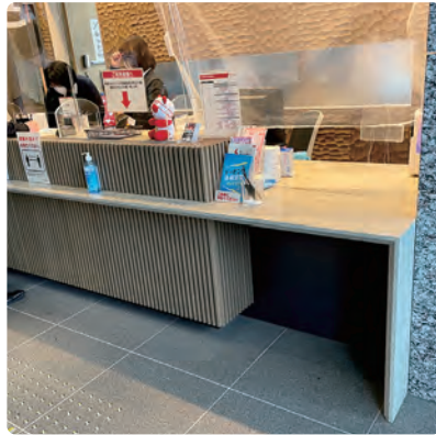
車椅子使用者に対応したカウンターを設置、車椅子使用者に配慮した位置に点字鋏を設置
