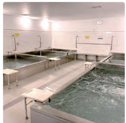
交代浴室には、浴槽への移乗動作をサポートする腰掛を設置 浴室床は、樹脂製のグレーチングで利用時の素足の安全性を確保
