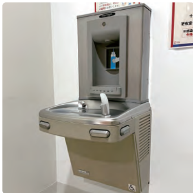
車椅子使用者に配慮した足元のスペースを確保、利き手などに配慮した押しボタンが付いた給水器を設置（水筒やペットボトル利用にも対応）
