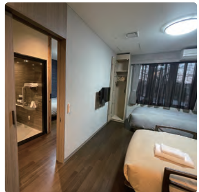
介添者との利用を想定した隣接する個室を繋げて利用できる宿泊室を設置（室内トイレ・シャワールームは車椅子使用可） 宿泊室には、引き出し式のハンガーを設置
