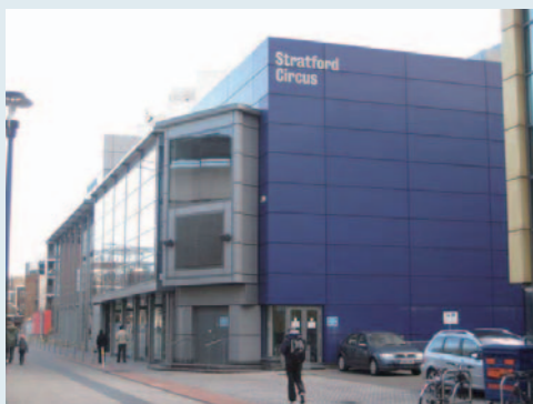
マルチサポート・ハウス設置予定のストラトフォード・サーカス
