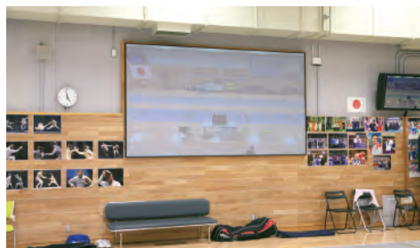
150インチブラックスクリーンを採用し、トレーニング中の明るい環境でもはっきりと映像を見ることが可能
