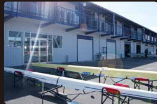
戸田艇庫 Toda Boat House
