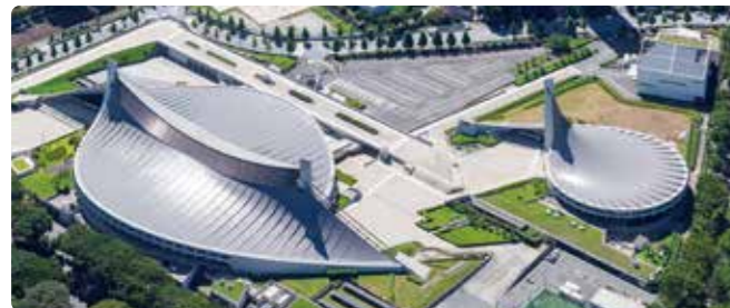
国立代々木競技場(第一体育館・第二体育館)を上空から
