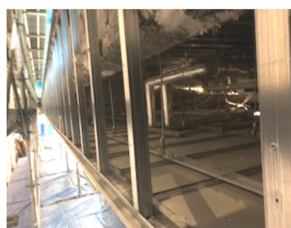
写真12 3階ボード撤去
