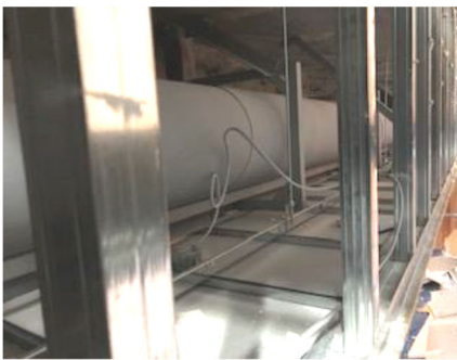
写真11 3階ボード撤去
