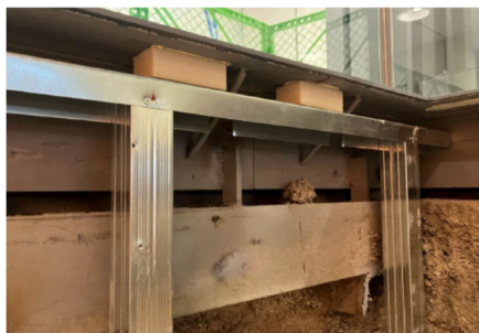
写真 17 崩落箇所と同様の施工
