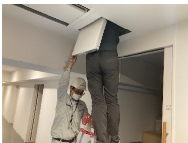
写真14 ①現地確認調査（天井点検口から内部を調査）
