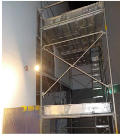
写真9 6階ボード撤去
