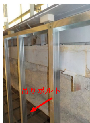
写真 19 プラレンガと吊りボルトを併用
