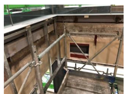
写真13 4階ボード撤去
