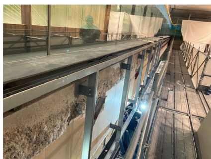
写真 22 壁下地の取付け
