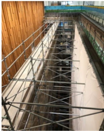
写真8 吹き抜け部分足場
