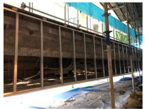
写真10 2階ボード撤去
