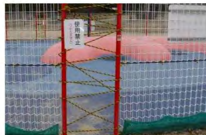
立入禁止措置状況
