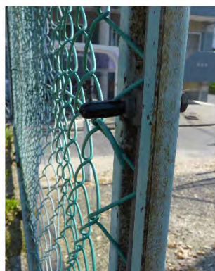
ボルト応急処置状況
