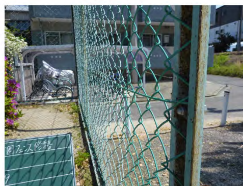
ボルト処置後
