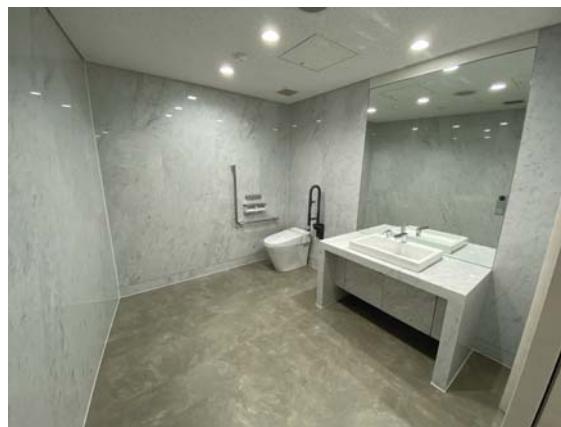
新設した車いす対応トイレ
