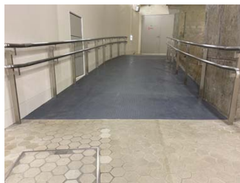
新設したスロープ手すり
