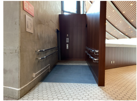
改修後 1階多目的トイレ前スロープ
