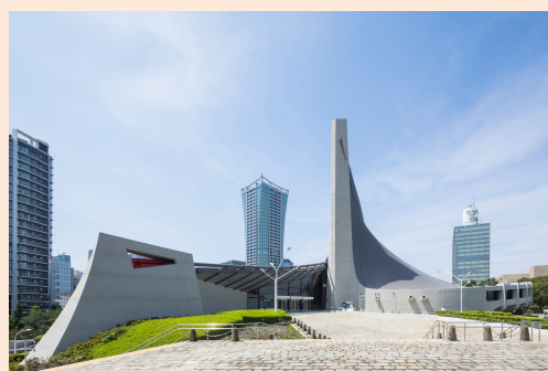
第二体育館外観
