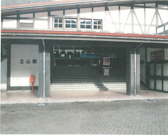
・立山駅正面出入口
