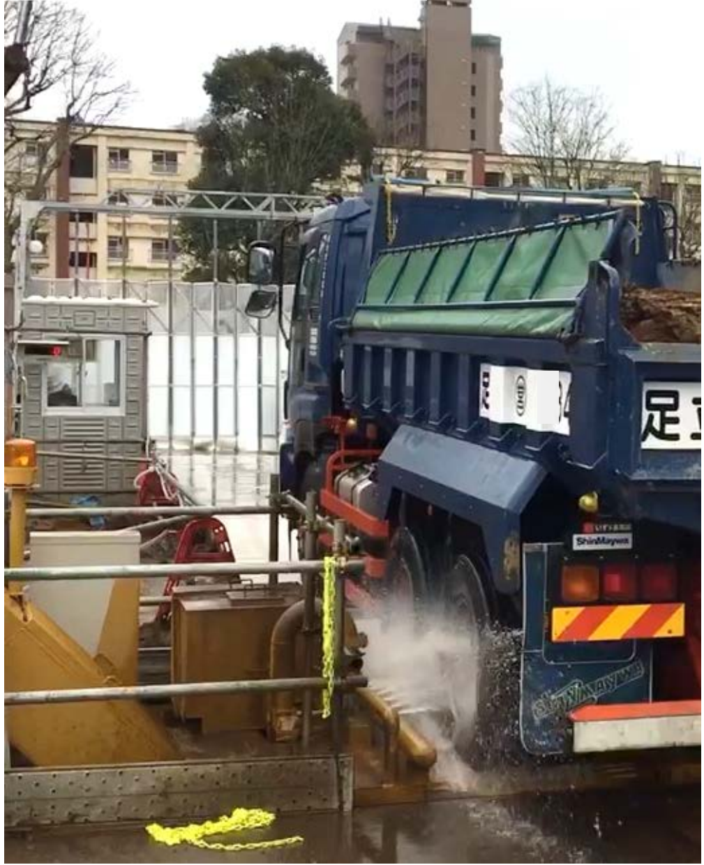
6 土砂運搬車輛のタイヤ洗浄
