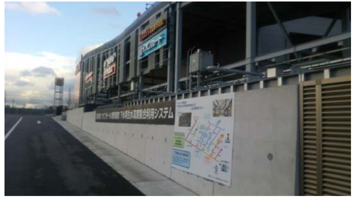
下水熱利用施設の紹介パネル
