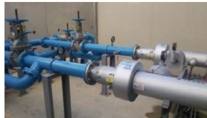
←下水処理水責任 分界点 (青配管まで下水道側 施設)
