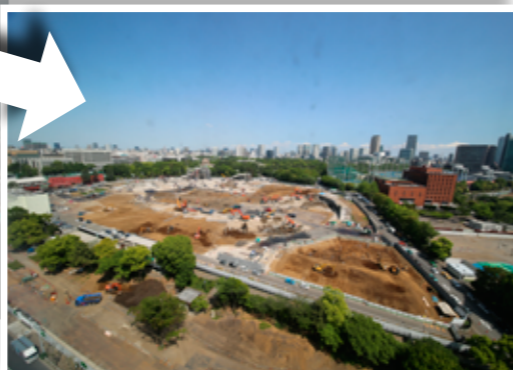
地上部躯体解体(5月1日)
