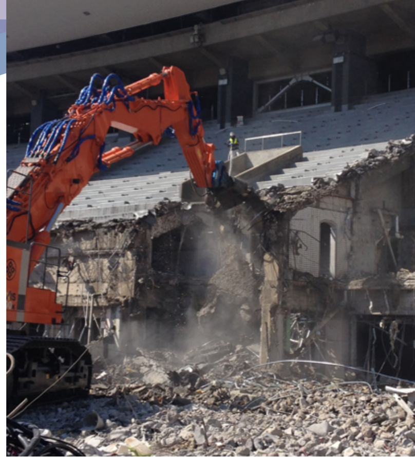
スタンドの解体
