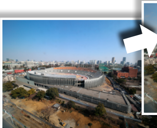
躯体解体前(2月15日)
