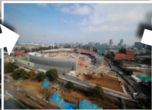
躯体解体途中(3月15日)
