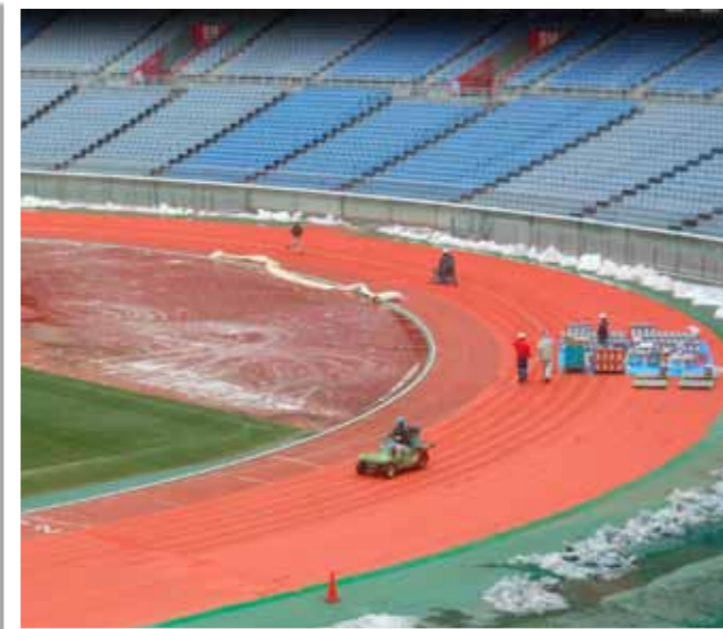
除雪した雪が残る中でのトラック塗装工事状況
