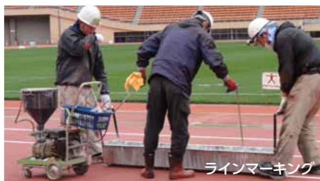
スタート部分補修
