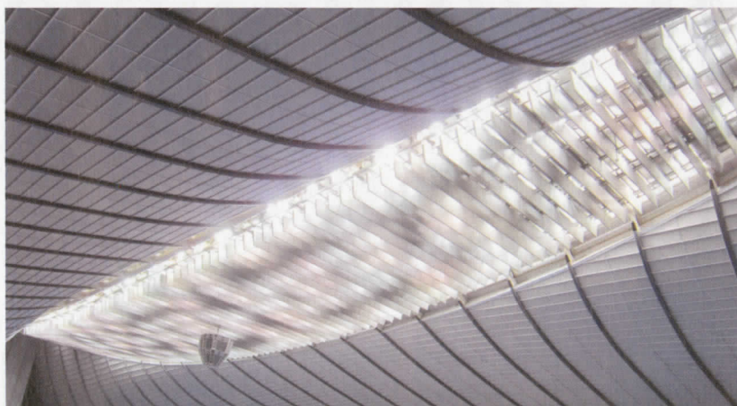
第一体育館の全点灯
