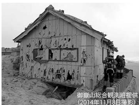
御嶽山総合観測班提供 (2014年11月8日撮影) 剣ヶ峰にある祈祷所の壁が、地獄谷からの噴石により破損している。(御嶽山合同観測班山頂調査班提供)
